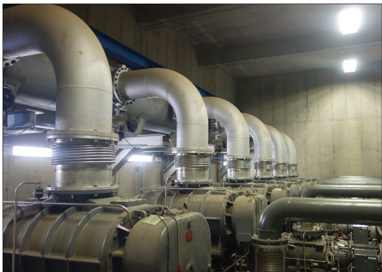
图 1 机械真空系统示例
